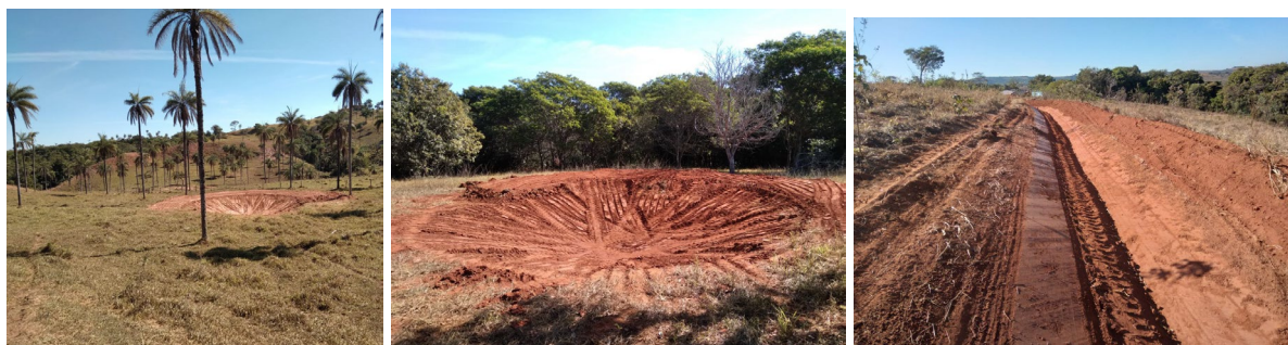
Fotos: Execução de obras no município de Tiros - MG
